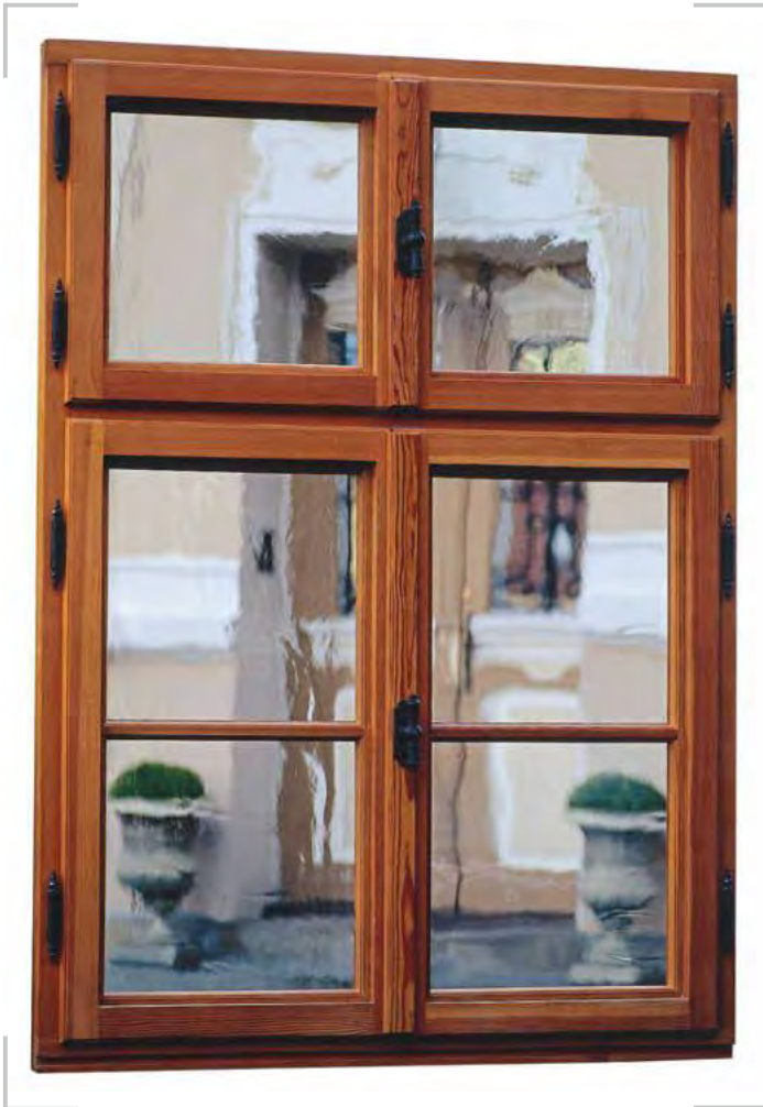
/ Restauo ist prädestiniert für die stilgetreue Restaurierung historischer Fenster- und Möbelverglasungen des beginnenden 20. Jahrhunderts und früherer Epochen.
